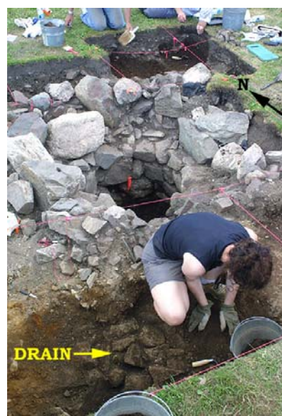
Vue du canal de drainage dans les unités K+L, qui s'étend en direction nord-est vers le puits
